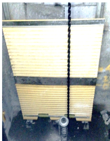
可使用鐵板防護
